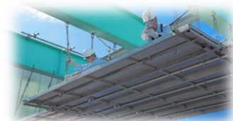
パネル式吊り棚足場 「SPIDER PANEL」
